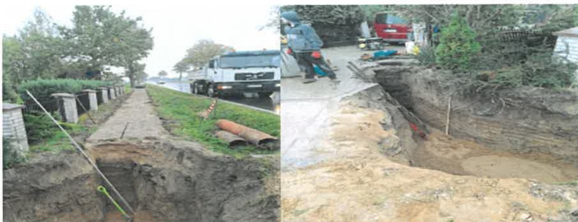
Zdjęcie 26: Rozbudowa kanalizacji sanitarnej.
